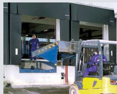
Desmontar la rampa niveladora antigua, en caso necesario adaptar la zanja (p. ej. con placas de montaje o consolas)
